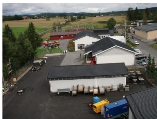
Elverkets anlegg på Løken
